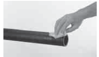
3. Sgrassare le superfici di saldatura con le nostre salviette detergenti oppure con carta assorbente bianca imbevuta di detergente adeguato. Non utilizzare carta colorata o panni sporchi.
