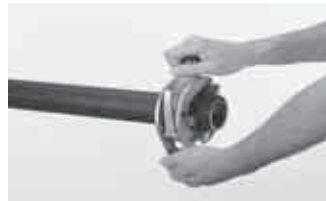
2. Rimuovere lo strato ossidato dai tubi, utilizzando raschiatubi automatici, spessore max 0,1-0,2 mm.
