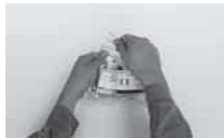
5. Estrarre il raccordo dall'imballo plastico. Se le parti saldabili sono state toccate con le mani, queste dovranno essere sgrassate (vedi punto 3).
