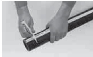
4. Contrassegnare la profondità d'inserimento sul tubo.
