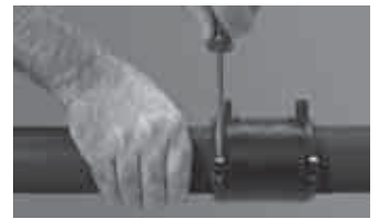
7a. Infilare il secondo tubo preparato analogamente nel raccordo e stringere le due viti.
